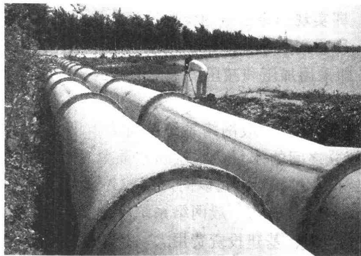
图 1.5 钢筋混凝土输水管道
