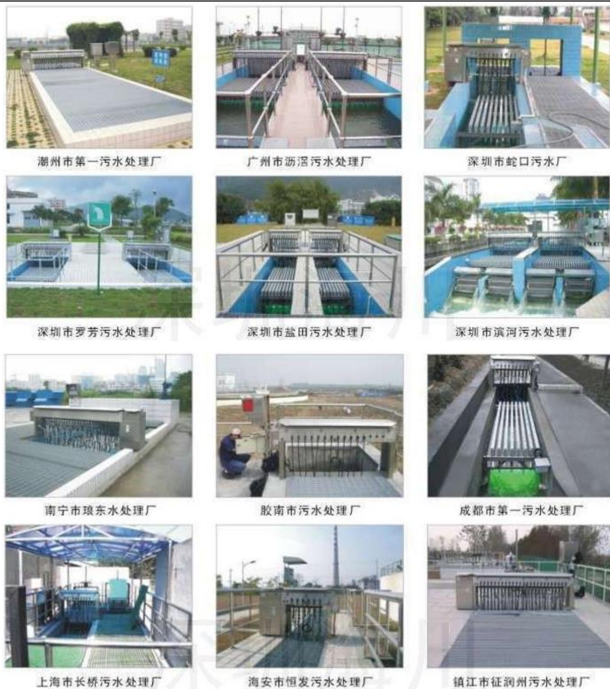
图 4.24 采用紫外 C 消毒技术的部分污水厂现场图
